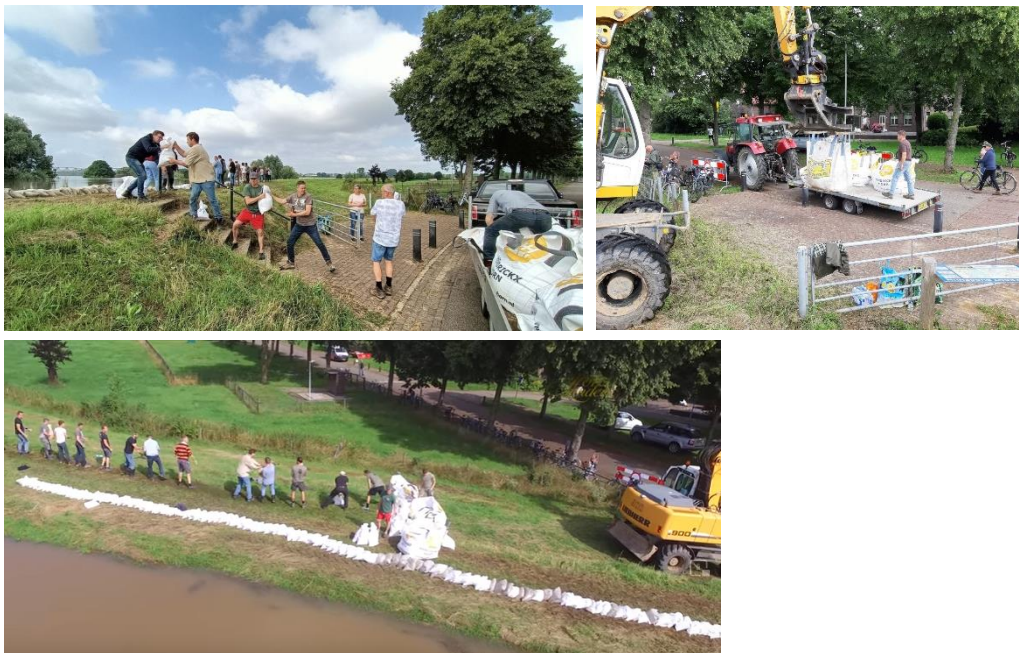
Figuur 4: met man en macht worden zandzakken op de dijk gelegd.
