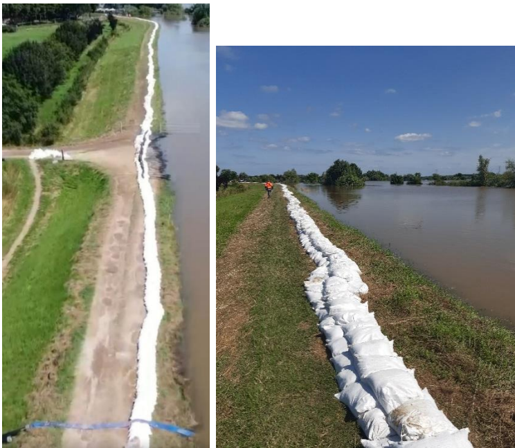
Figuur 5: zandzakken op de dijk.
